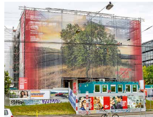
La reconstruction de l'église du Sacré-Cœur est en cours au centre de Genève.
